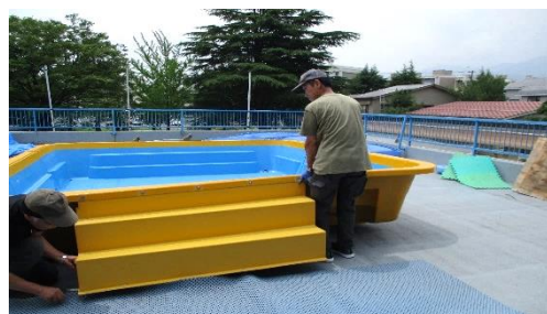
▲ 保育園士によるプール設置作業の様子
