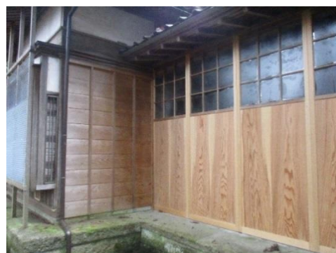
▲ 白田邸 改修が完了した外壁と木製雨戸
