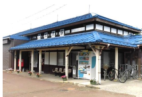
▲ 二本木駅 改修が完了した駅舎
